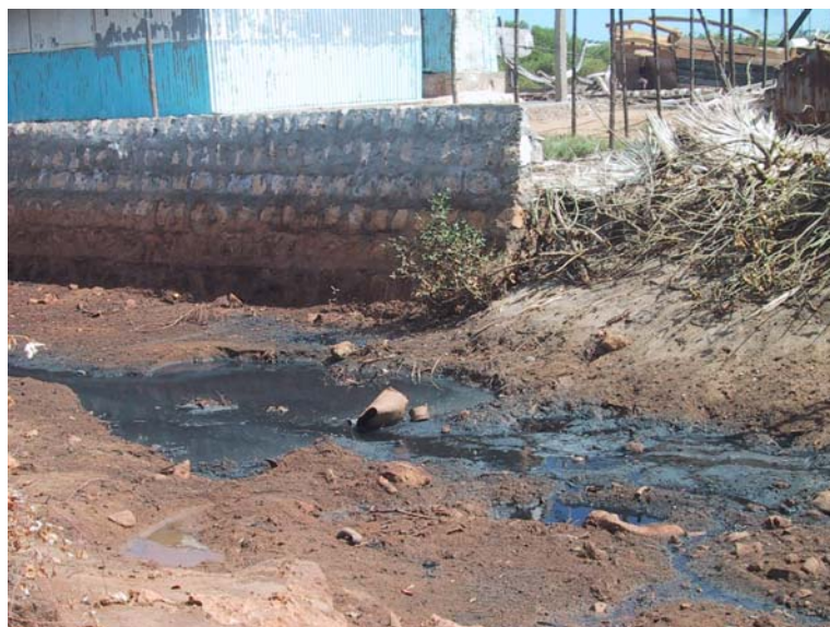
Figura 4: Parte finale (non rivestita in cemento) del canale di evacuazione dei reflui della SIB.
